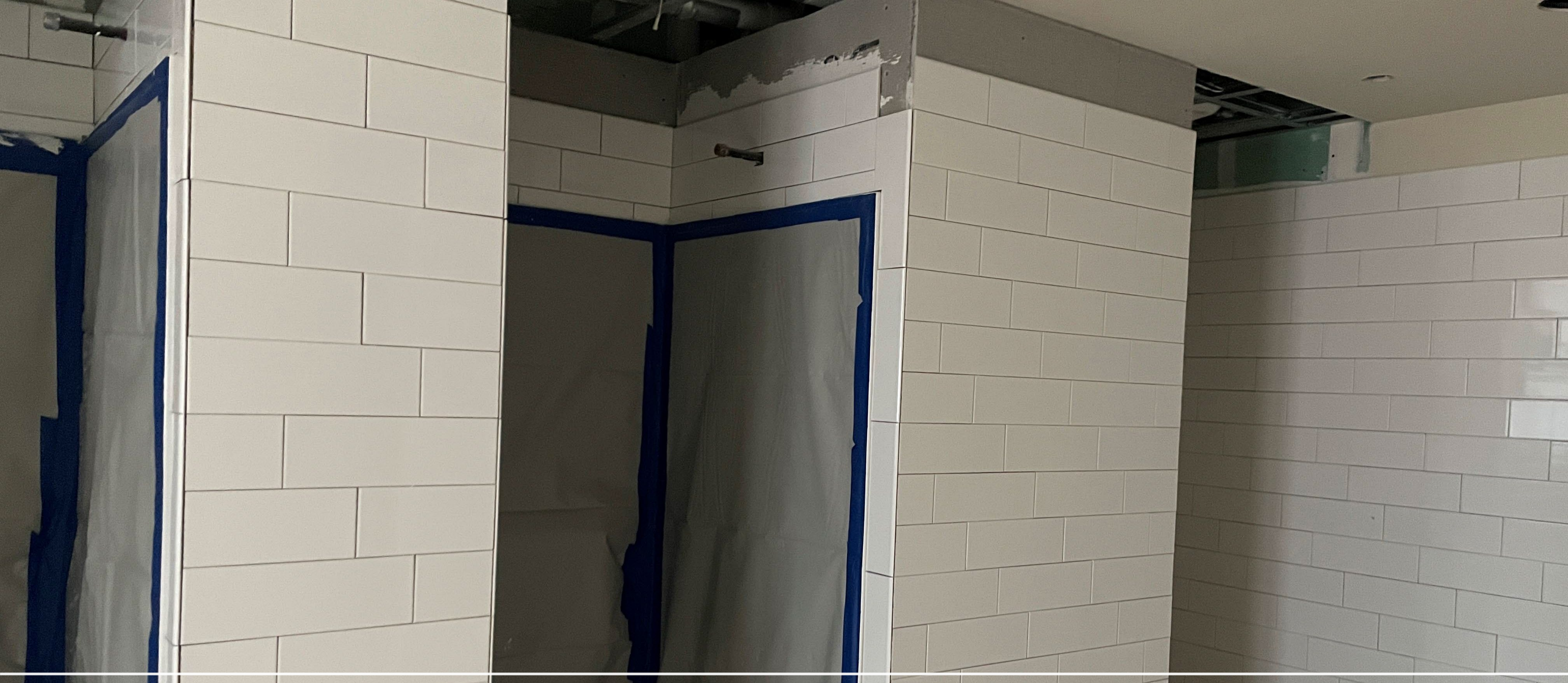
Restroom Tile (Alamito)
